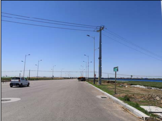
场地西侧（镜向南）北京路
