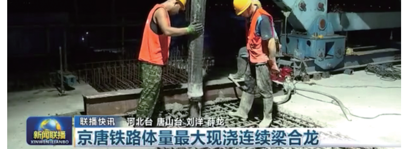
京唐铁路体量最大现浇连续梁合龙
